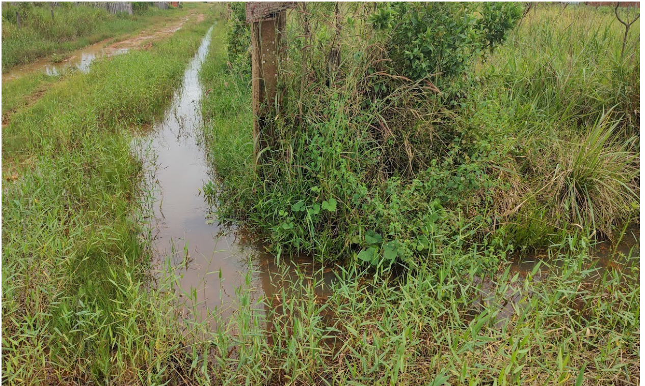
Água nas laterais e no leito da via
