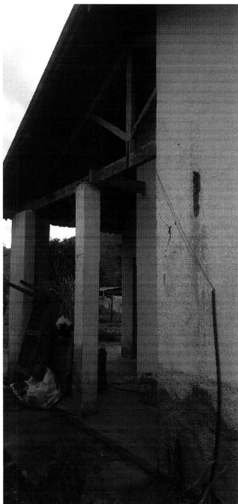
Imagem 02 – Fundos do Imóvel
