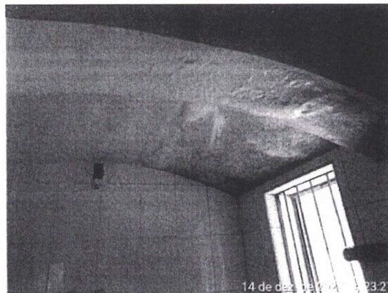
FOTO 30: Banheiro da Secretaria
