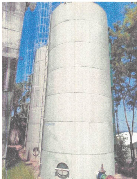
Figura 30 – Reservatórios cilíndricos inaugurados em 2015
