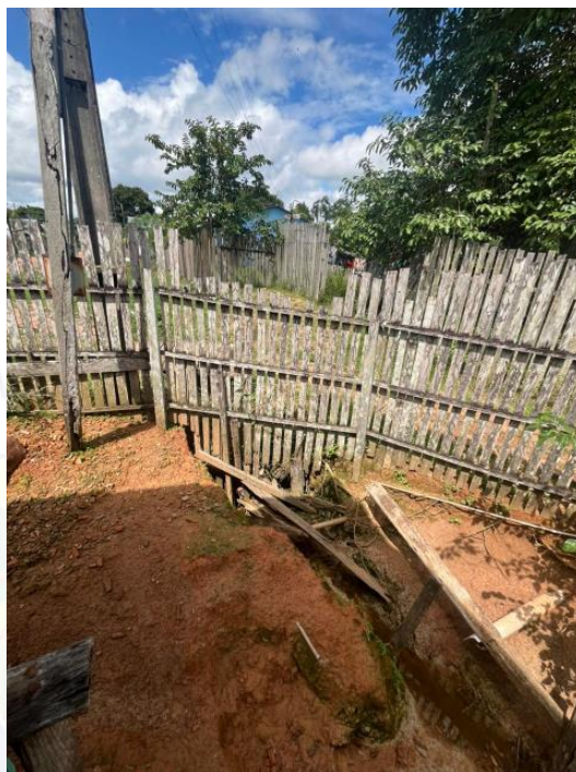
Onde é necessário a construção da caixa pluvial
