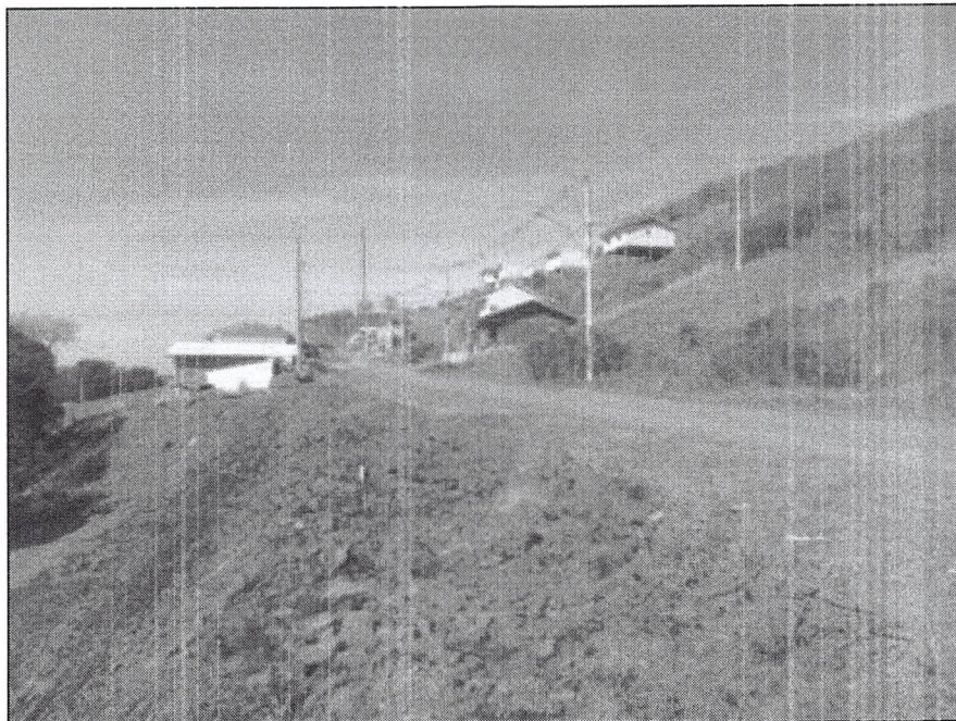
Figura 5.26 – Aterramento para a implantação da Rua Padre Sergio Calza e lotes da Quadra B, com destaque para a acentuada inclinação e sem proteção.
