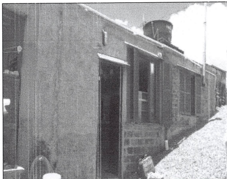
Figura 6.32 - Vista lateral da edificação do Lote 3.
