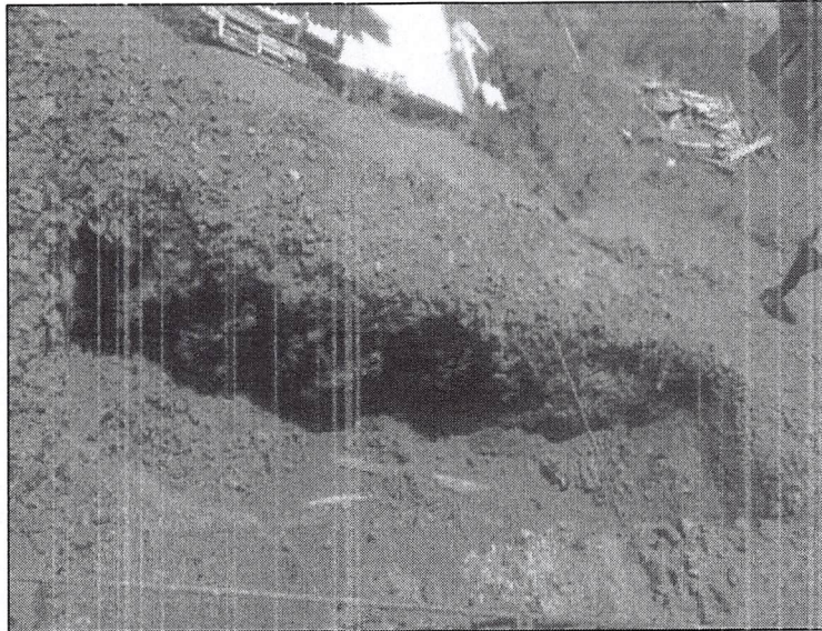
Figura 6.15 - Vala para implantação de sistema de fossa filtro, aberta nos fundos do terreno do Lote 8.
