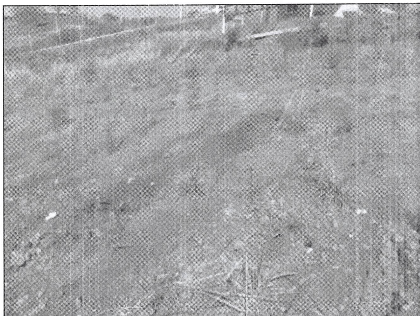
Figura 5.28 – Processos de erosão superficial (ravinamento) em depósitos coluvionares, solos e parte de aterro, adjacente à Quadra C, com projeção para dentro do loteamento em questão.
