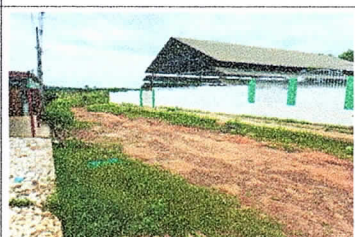
Foto 12 – Vista oposta do trecho
