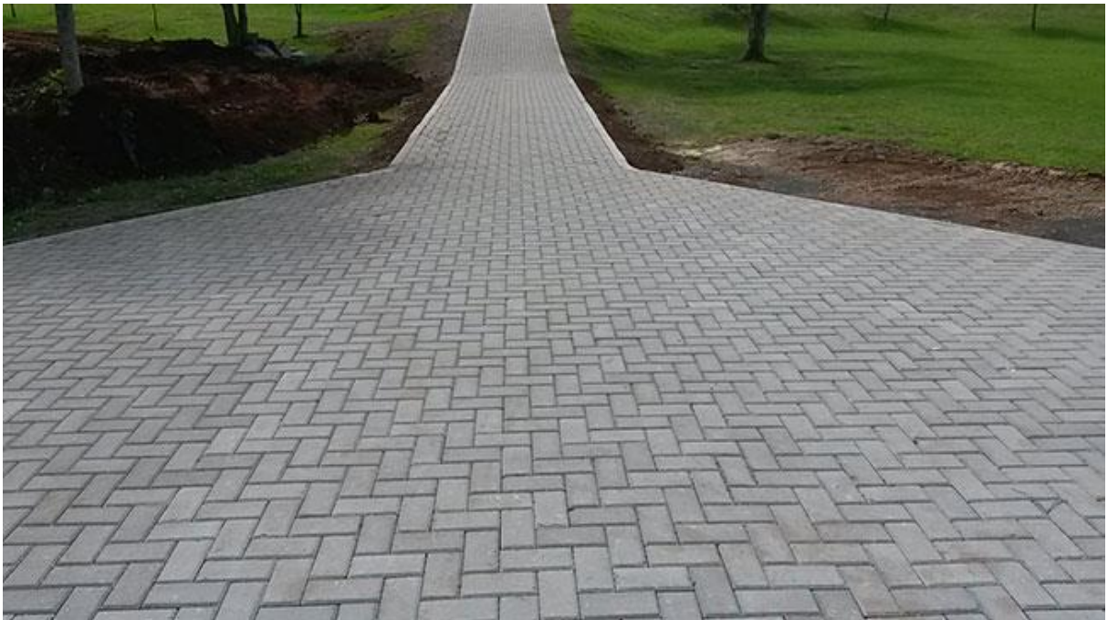
Figura: Pavimento de Blocos Intertravados.
