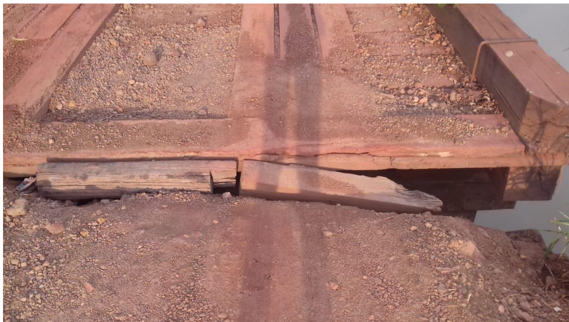
Foto 1 – Cabeceira da Ponte de Linha 33
