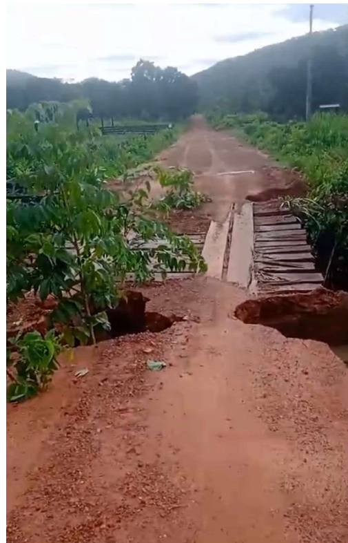
Ponte na comunidade Facão
