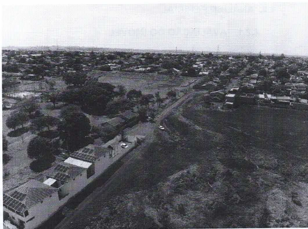
Imagem 9: Vista aérea do terreno.
