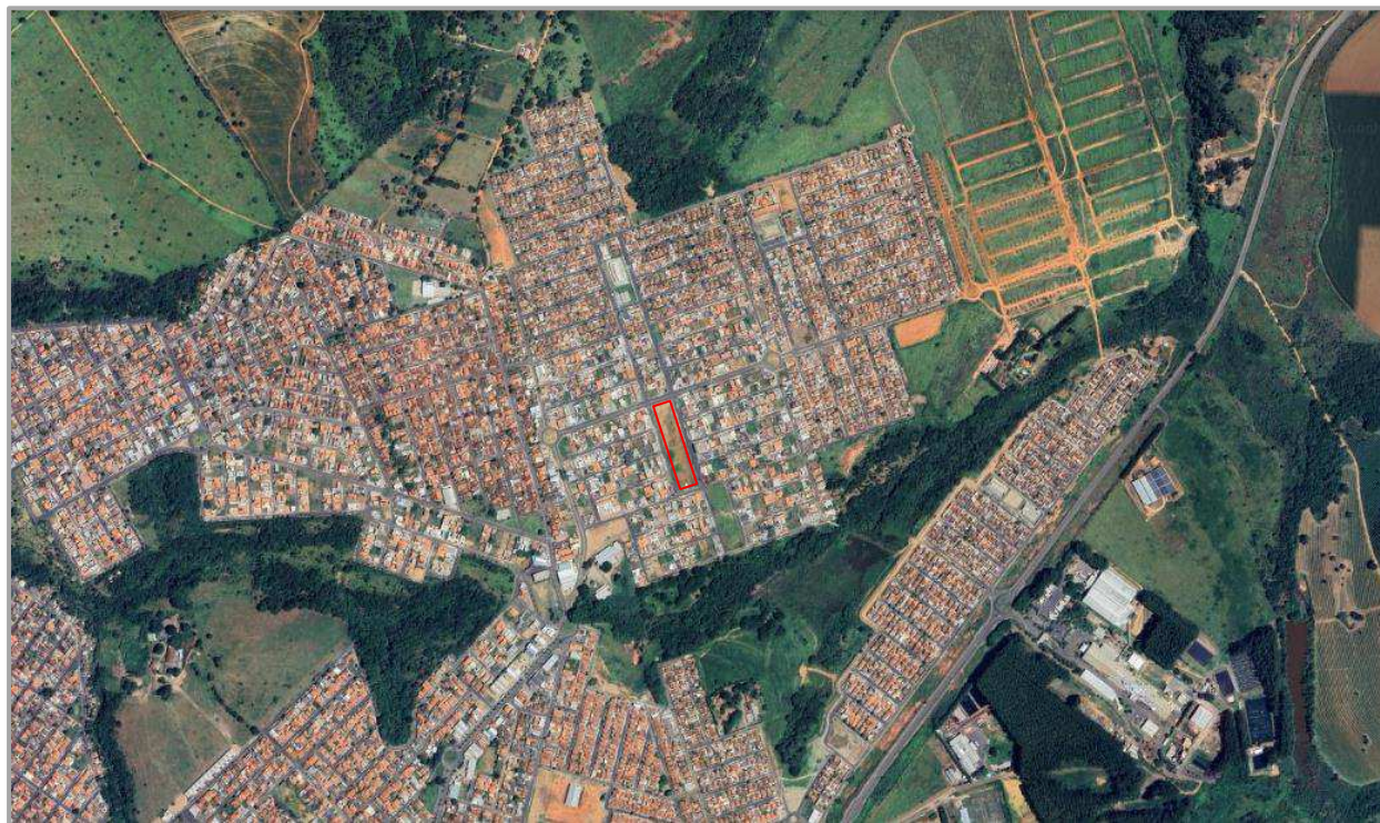
Imagem 02– Imóvel avaliando Fonte – Google Maps
