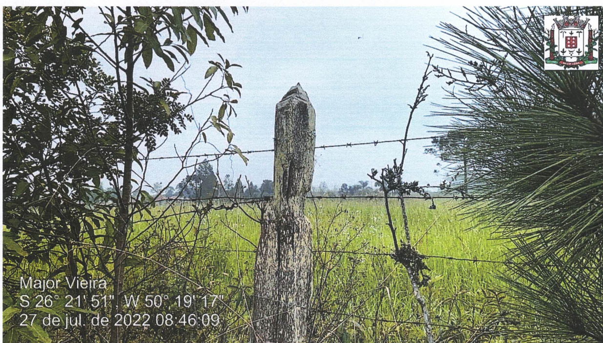
2- IMÓVEL 02. FONTE: O AUTOR
