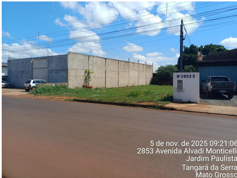
Figura 04 - Vista do imóvel
