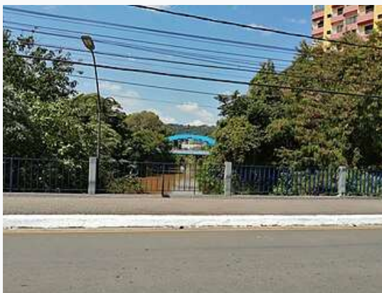
Ponte sobre córrego na cidade.
