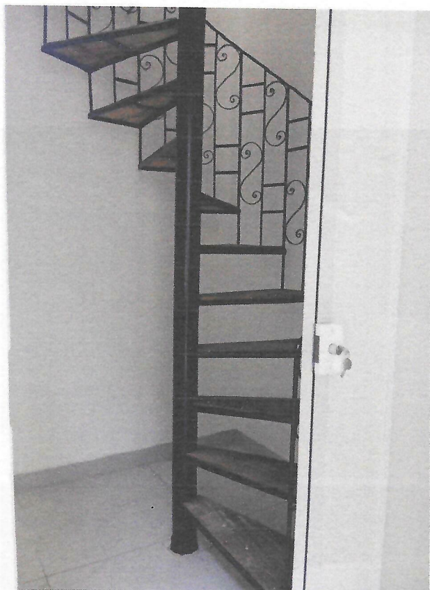
Acesso ao pavimento superior por escada helicoidal com estrutura metálica e degraus em madeira. Acesso que pode ser fechado com a porta de blindex.
