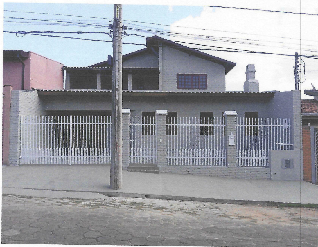
Fachada da residência com grades de proteção e telhado aparente, ambas com pintura nova, valorizando a segurança e o acabamento do imóvel.
