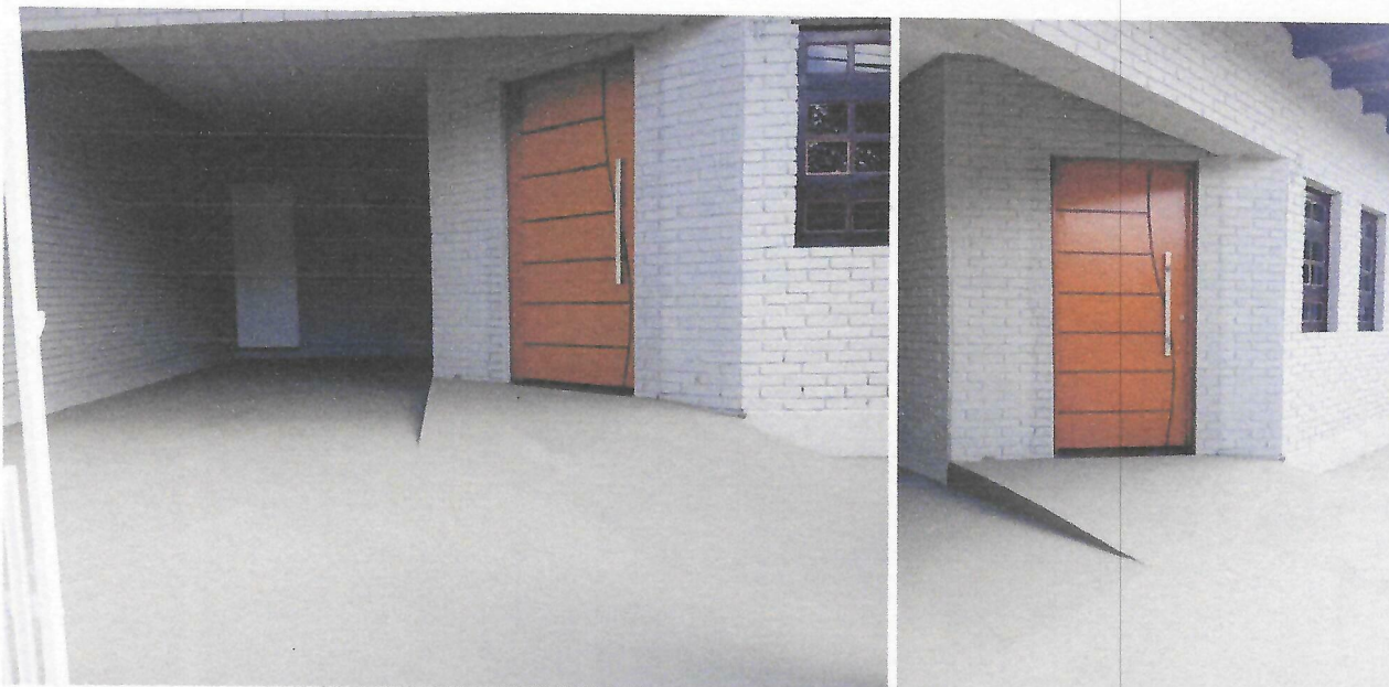
Entrada Acessível pelo abrigo para dois veículos que contém 22,01m 2 em piso de cimento.
