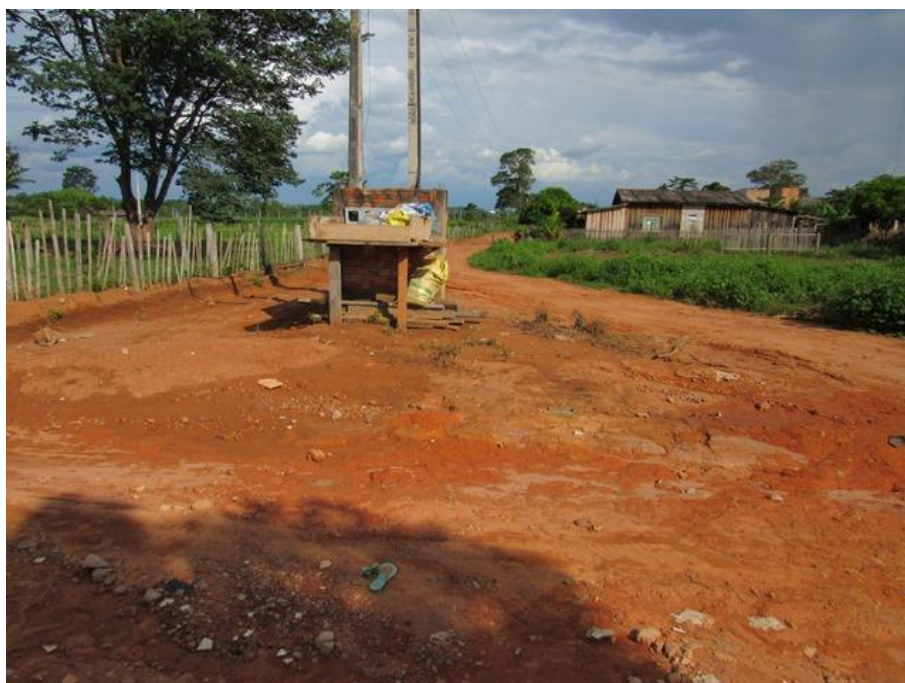
Medidores de energia e lixeira concentrados na Rua Roobysom F. Ribeiro.
