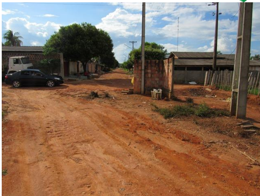
Hidrômetros concentrados na Rua Roobysom F. Ribeiro.
