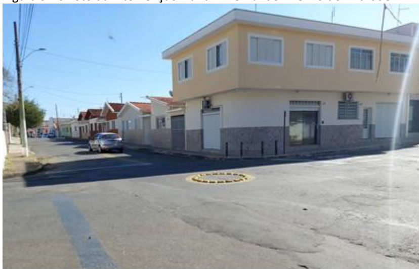
Figura 5-26 Foto da intervenção viária R. Fernando Avelino de Andrade – mini-rotatórias (fase 1)
