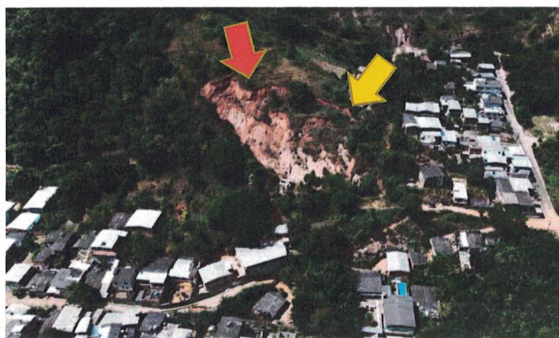
Foto 3 - Localização: Erosão da rua Alemanha; Data da foto: 25/01/2022; Obs.: Surgimento de novos deslizamentos devido ao surgimento de novas trincas.
