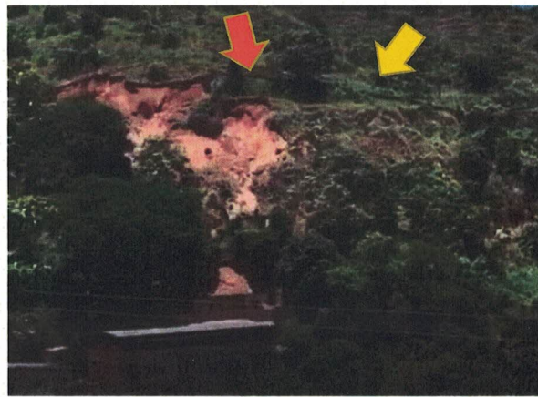
Foto 2 - Localização: Erosão da rua Alemanha; Data da foto: 22/01/2022; Obs.: Surgimento de uma trinca indicada pela seta amarela e crescimento da erosão indicado pela seta amarela.
