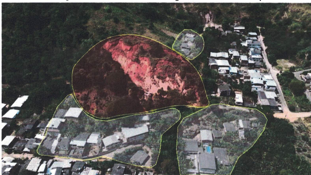
Localização da área de risco a escorregamento indicada e mapeada
