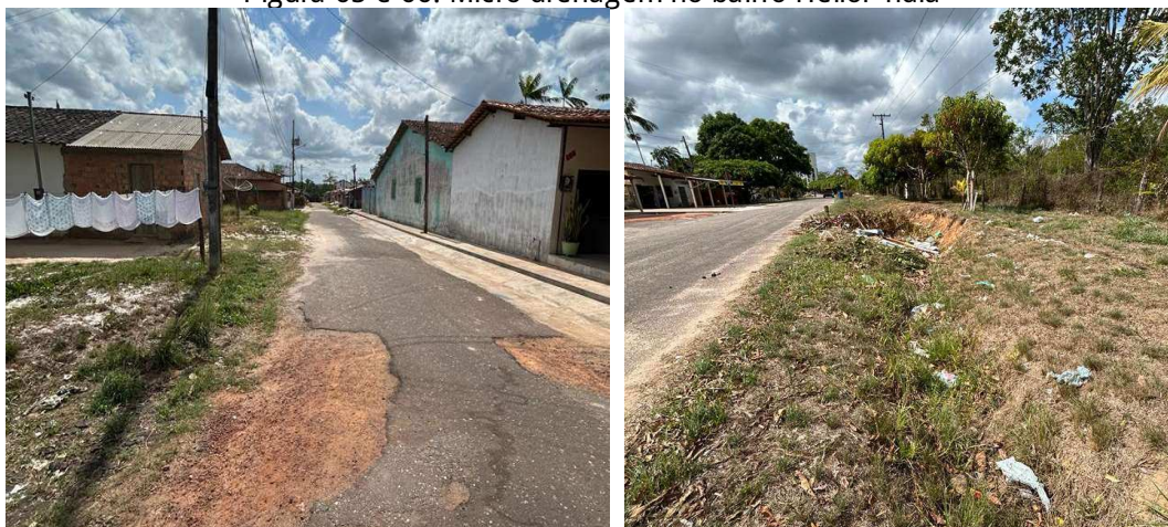
Figura 65 e 66: Micro drenagem no bairro Heliolândia
