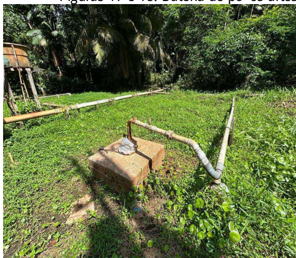
Figuras 17 e 18: Bateria de poços artesanais utilizados para captação de água.
