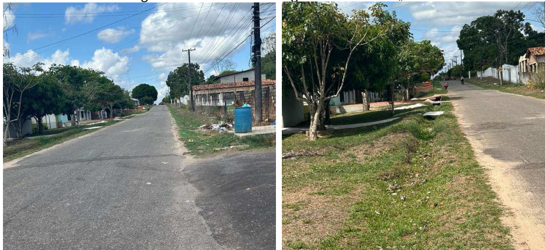
Figura 61 e 62: Micro drenagem no bairro América
