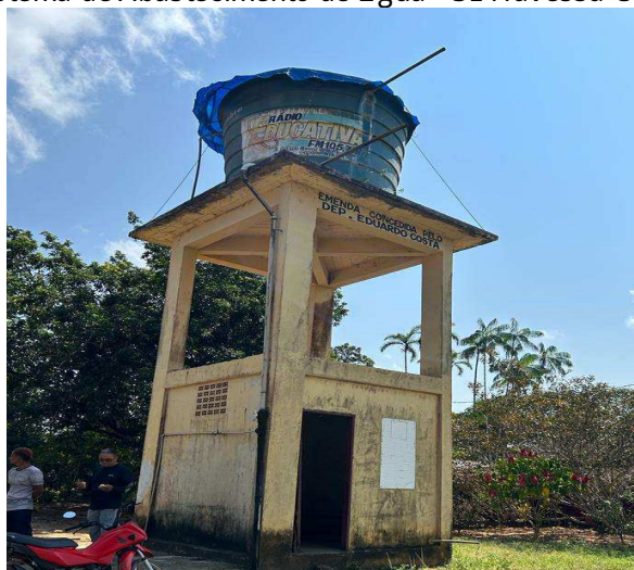
Figura 33: Microssistema de Abastecimento de Água - 3ª Travessa Colônia Pedro Teixeira
