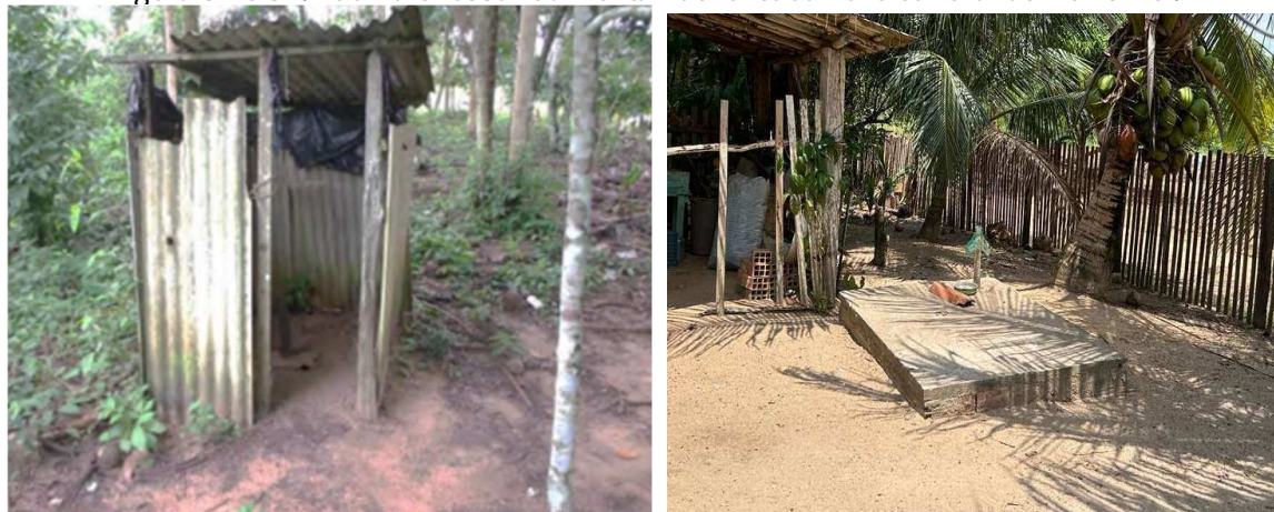
Figura 51 e 52: Latrina e fossa rudimentar identificada na área rural de Peixe-Boi.
