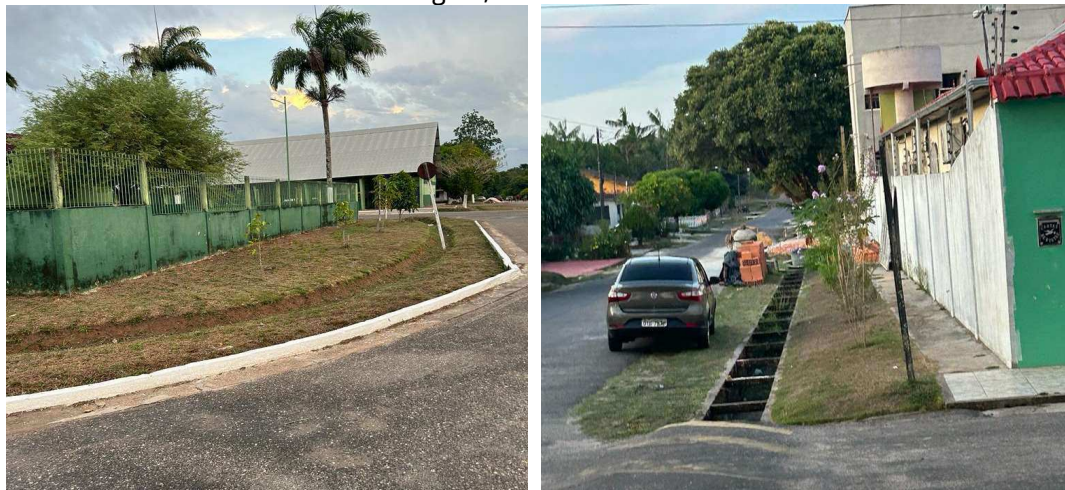
Figura 57 e 58: Sistema de Micro drenagem, conduto em concreto - Bairro Centro/Sede Municipal
