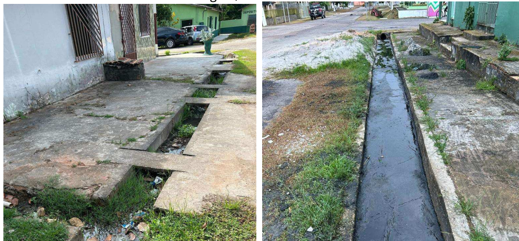
Figura 55 e 56: Sistema de Micro drenagem, conduto em concreto - Bairro Centro/Sede Municipal
