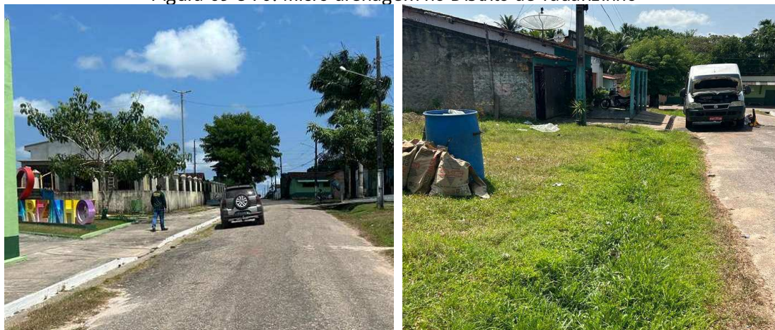
Figura 69 e 70: Micro drenagem no Distrito de Tauarizinho
