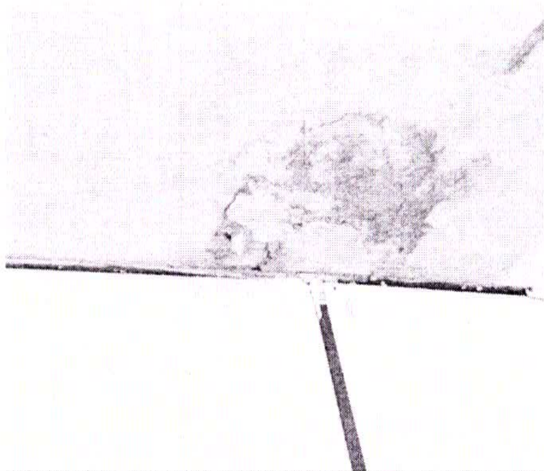
Danos causados no forro devido infiltração/goteiras
