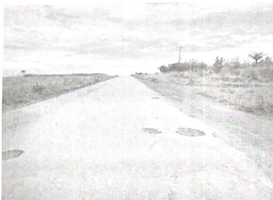
Imagem que retrata o estado da RO - 494.
