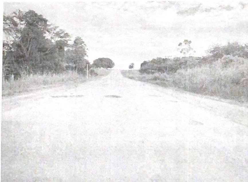
Imagem que retrata o estado da RO – 494.
