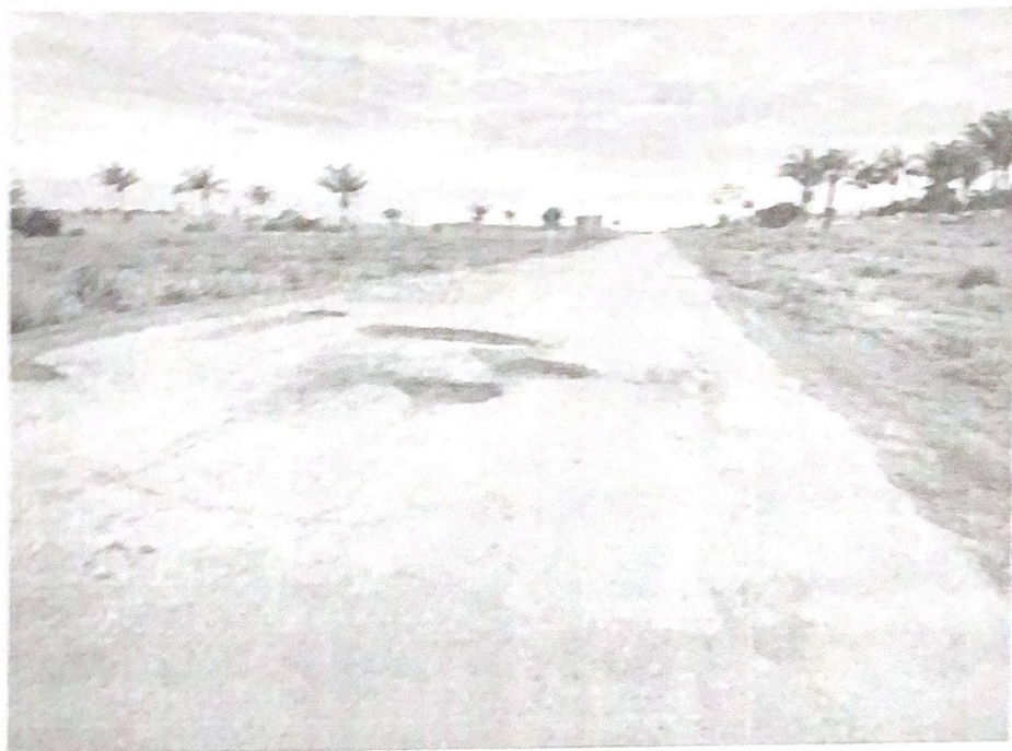
Imagem que retrata o estado da RO - 494.
