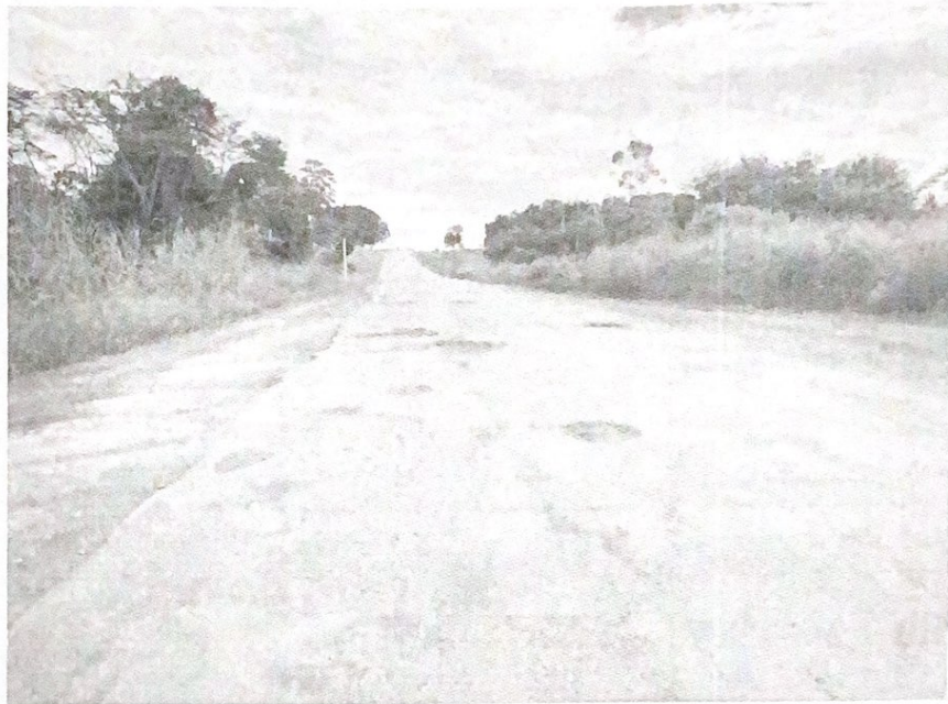
Imagem que retrata o estado da RO – 494.
