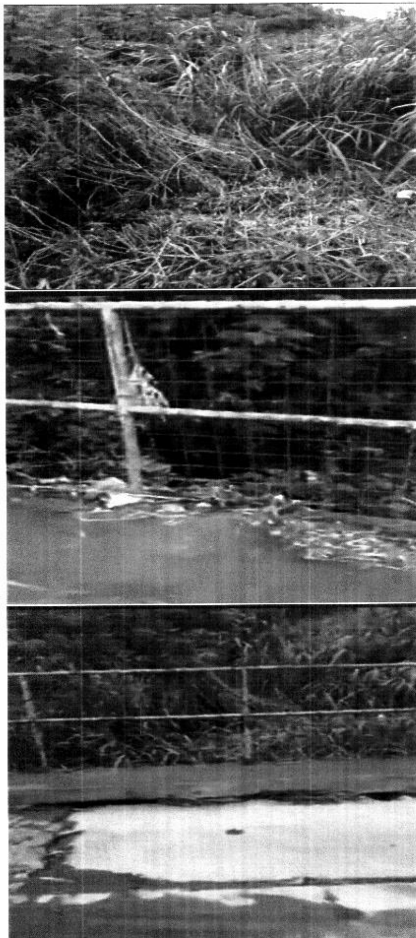
PONTE SOBRE O CORREGO DE ACESSO A RUA F ,TANQUINHO 2
