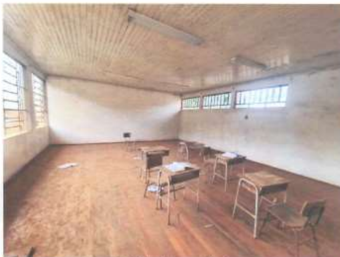
foto 11: área interna a edificação
