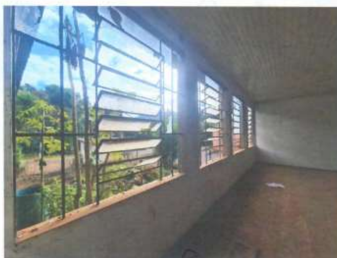
foto 12: área interna a edificação
