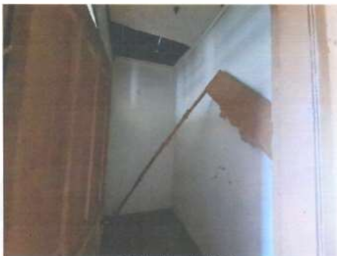
foto 05: área interna da edificação
