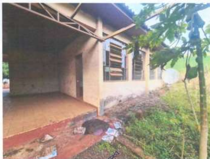
foto 02: área externa da edificação
