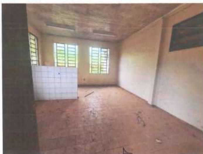
foto 08: área interna da edificação
