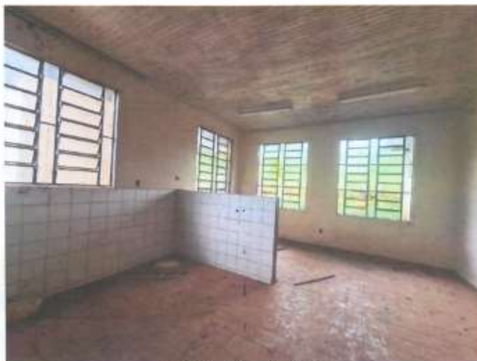
foto 09: área interna da edificação
