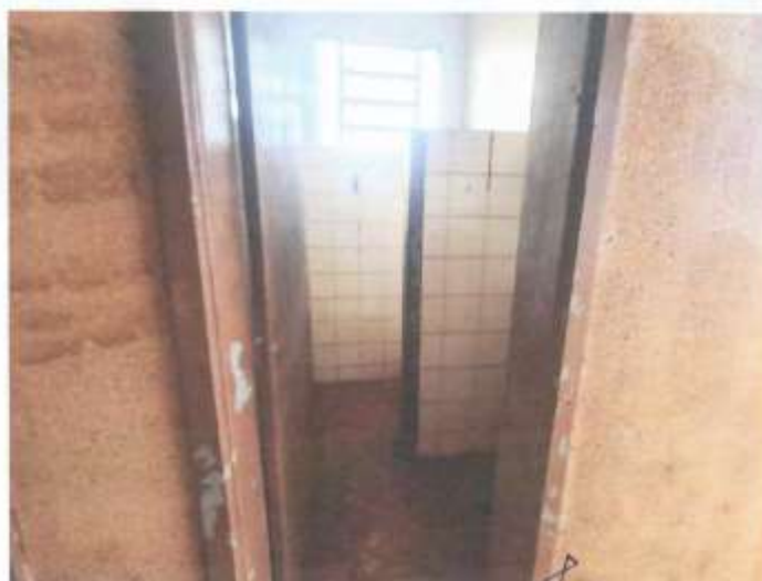
foto 06: área interna da edificação
