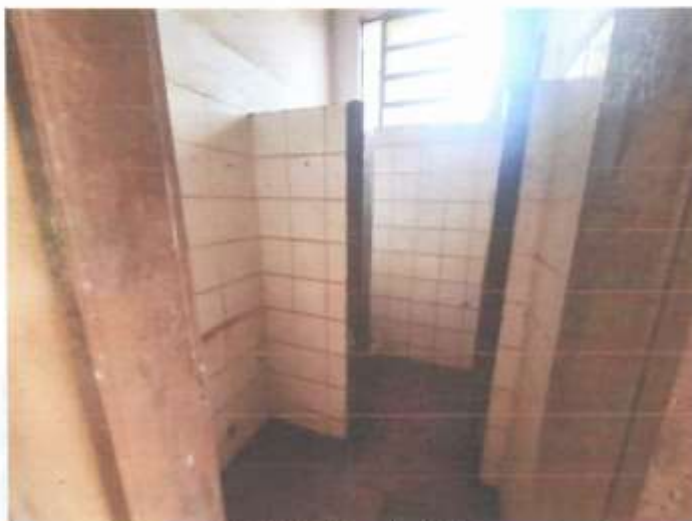
foto 07: área interna da edificação
