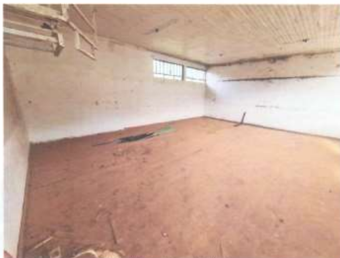
foto 03: área interna de edificação
