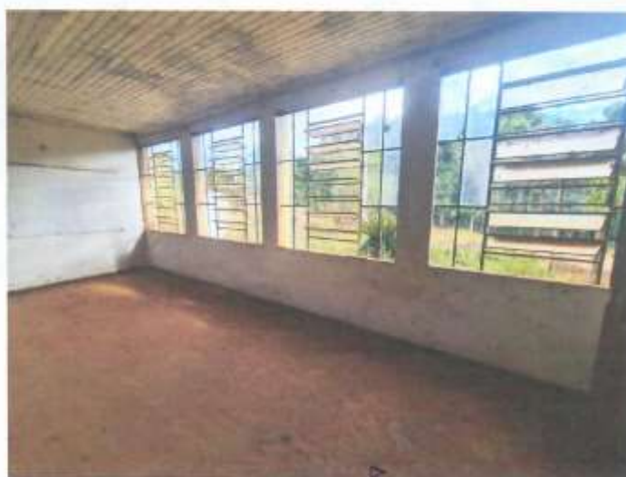
foto 04: área interna de edificação
