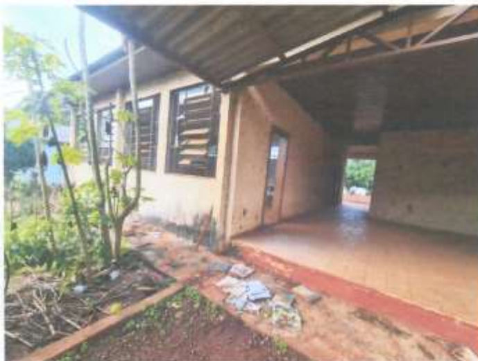
foto 01: área externa da edificação
