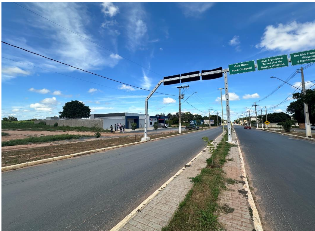
Figura 9 – Vista da Avenida Montes Claros, em frente ao terreno vistoriado.
