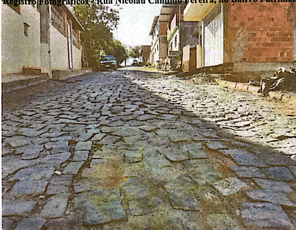
Registro Fotográfico - Rua Nicolau Cândido Pereira, no Bairro Patrimônio
