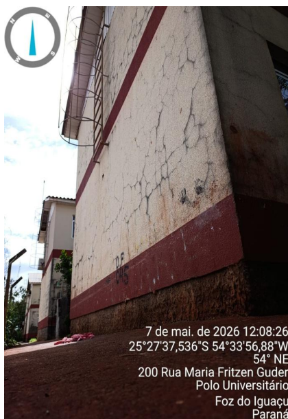
Imagem 3: Vista geral do conjunto, com trincas análogas às constatadas no Bloco 4.
