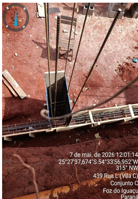
Imagem 9 - Vista superior da estrutura de fundação do muro, em execução pelo vizinho.
