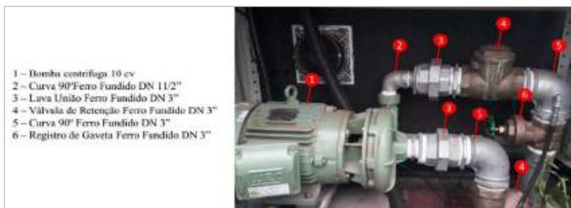
Figura 35— Detalhes do barrilete do booster do SAA de Pimenta Bueno.
