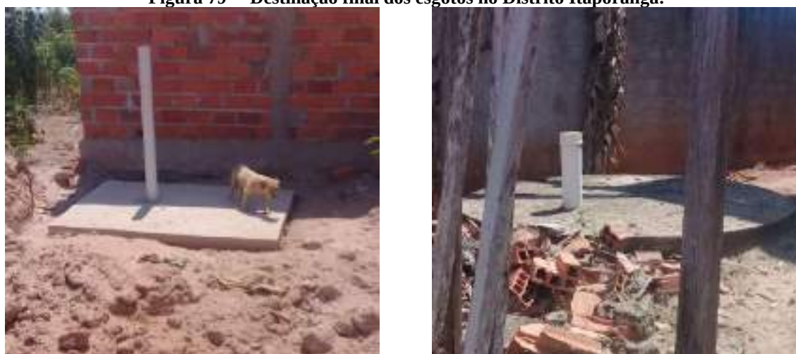
Figura 79— Destinação final dos esgotos no Distrito Itaporanga.
