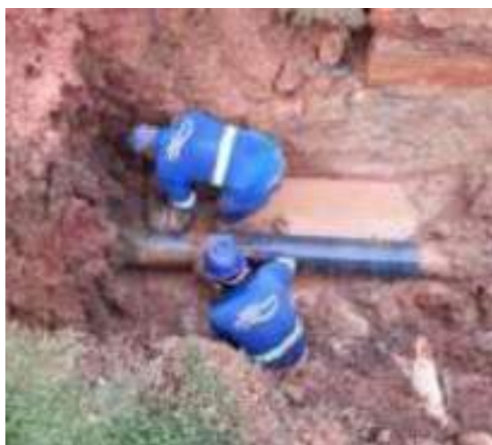
Figura 39— Reparo na adutora de água tratada DEFºFº DN 200 mm na R. Raposo Tavares.
