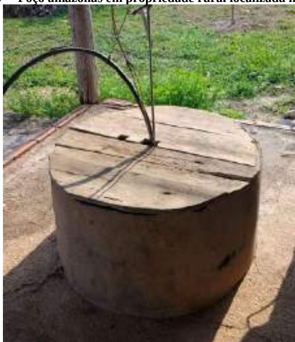
Figura 60— Poço amazonas em propriedade rural localizada na linha 15.
