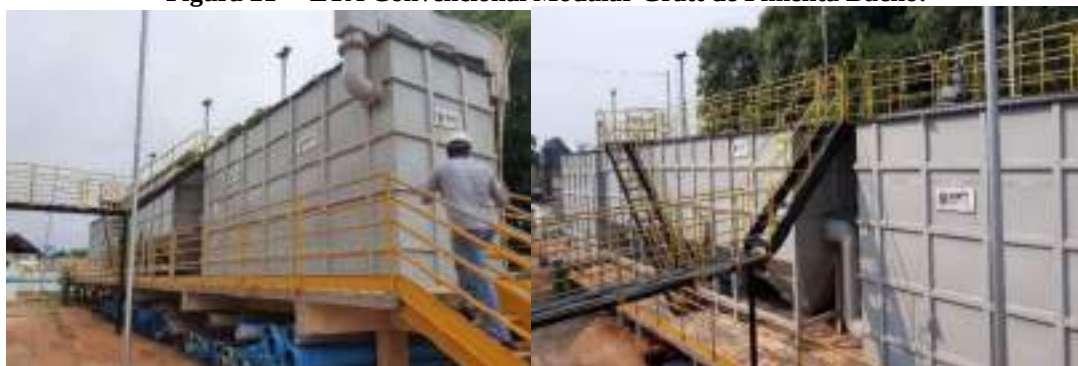
Figura 21— ETA Convencional Modular Gratt de Pimenta Bueno.
