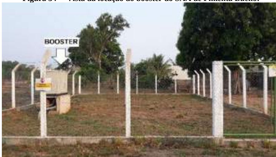
Figura 34— Vista da locação do booster do SAA de Pimenta Bueno.
