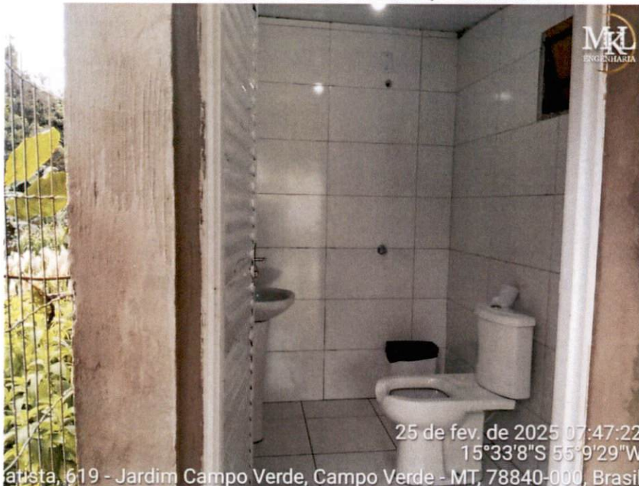
Anexo A42 – Banheiro externo da edificação aos fundos
