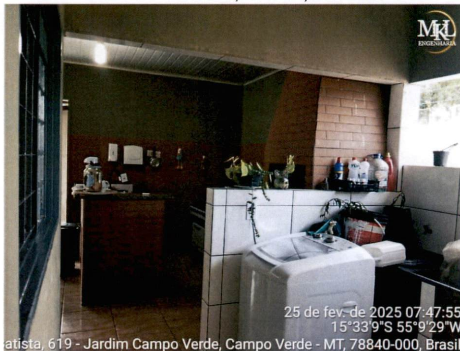
Anexo A37 – Área de serviço da edificação aos fundos
