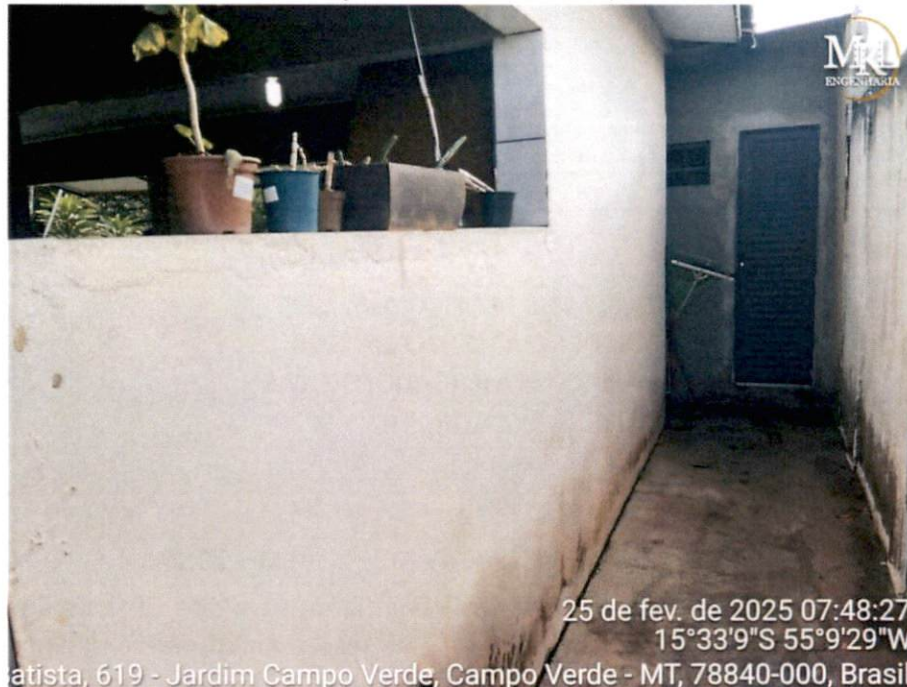
Anexo A43 – Depósito externo da edificação aos fundos
