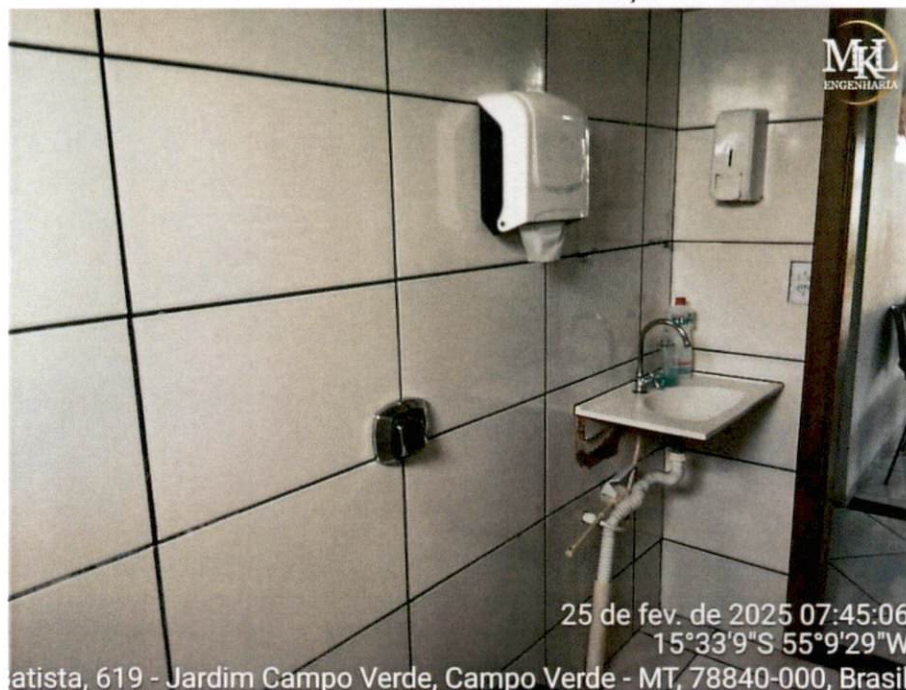
Anexo A33 – Banheiro do corredor da edificação aos fundos
