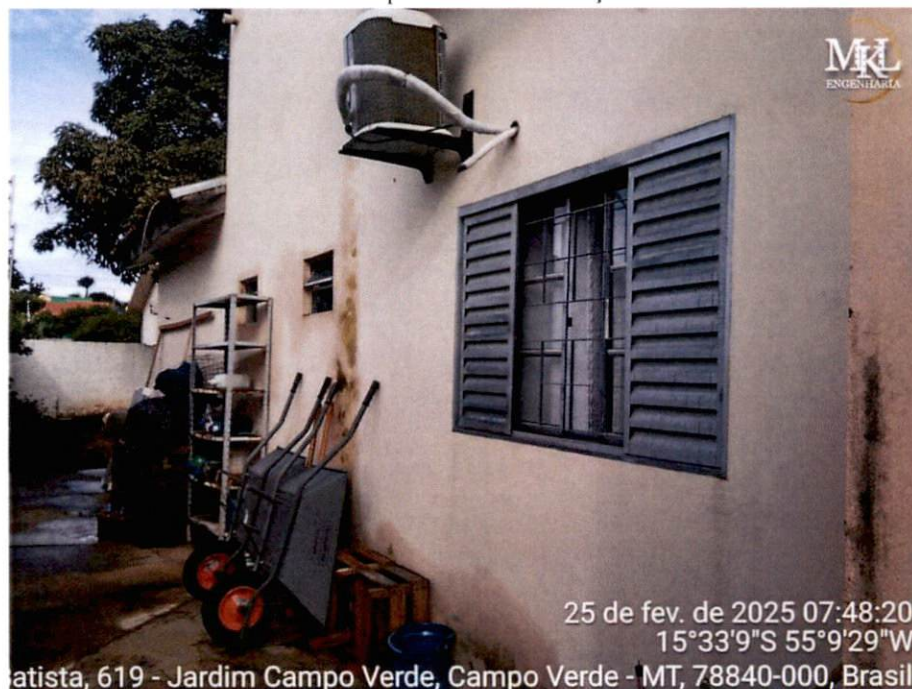
Anexo A44 – Vista posterior da edificação aos fundos
