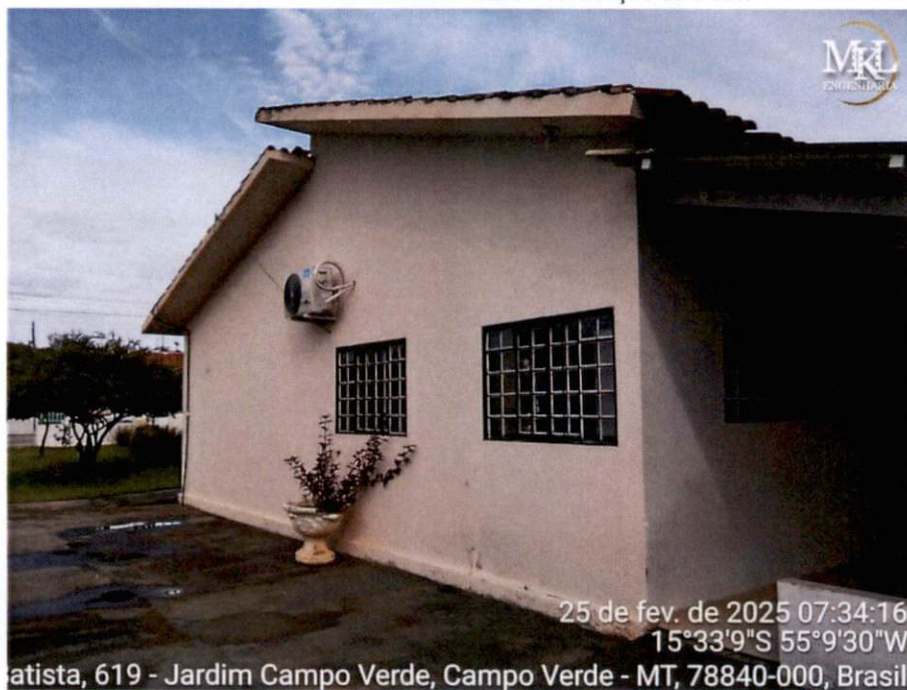
Anexo A6 – Vista lateral direita da edificação da frente
