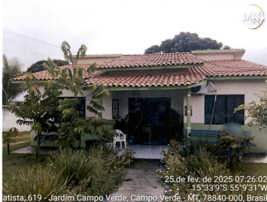
Anexo A5 – Vista da frente da edificação da frente (casa de frente para o logradouro)
