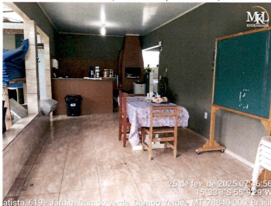
Anexo A39 – Área de alimentação com churrasqueira da edificação aos fundos
