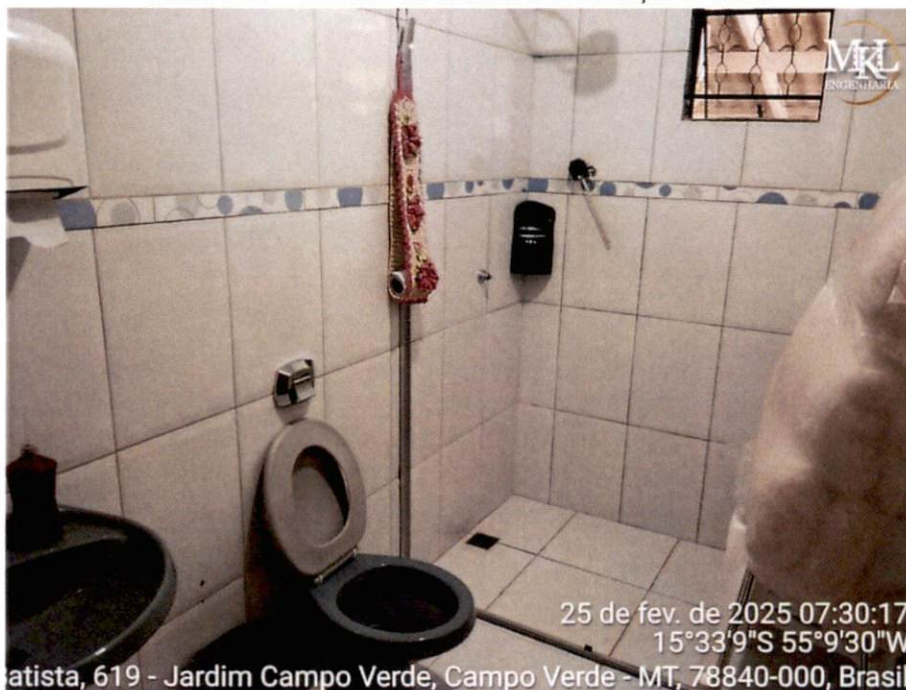
Anexo A20 – Banheiro do corredor da edificação da frente
