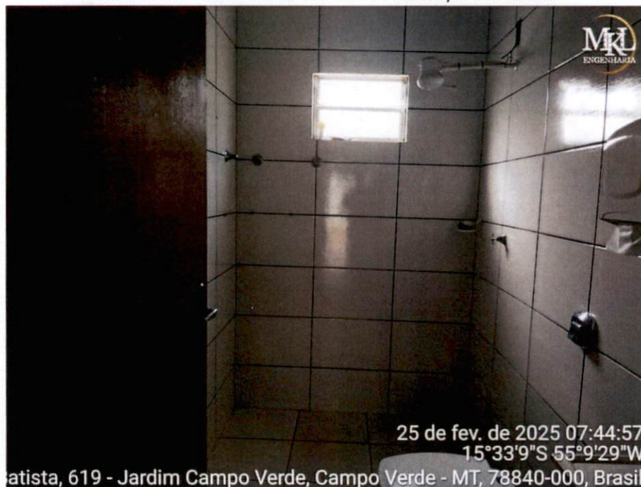
Anexo A34 – Banheiro do corredor da edificação aos fundos
