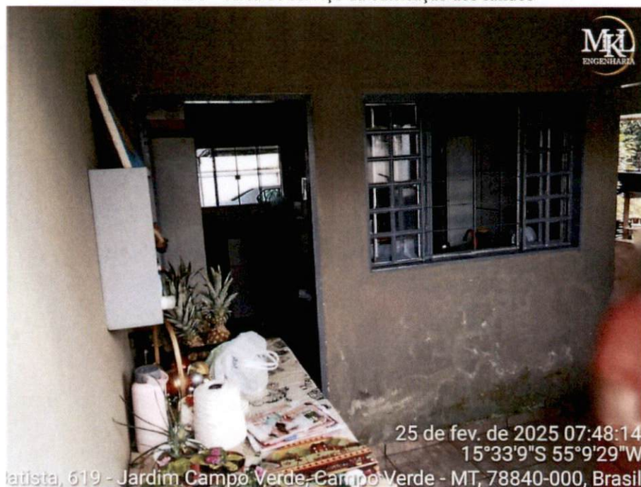
Anexo A38 – Área de serviço da edificação aos fundos
