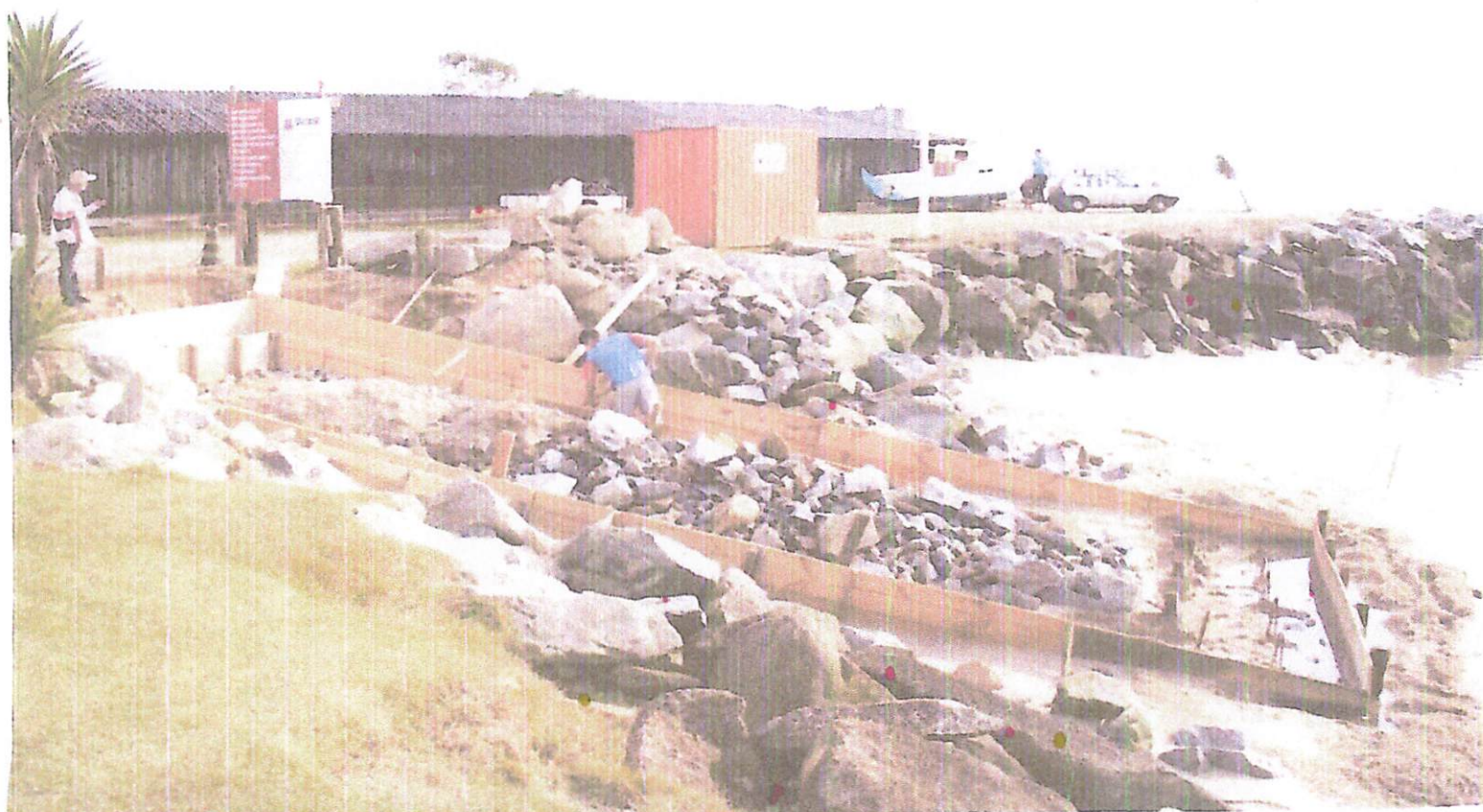
Rampa construída na Beira-Mar
