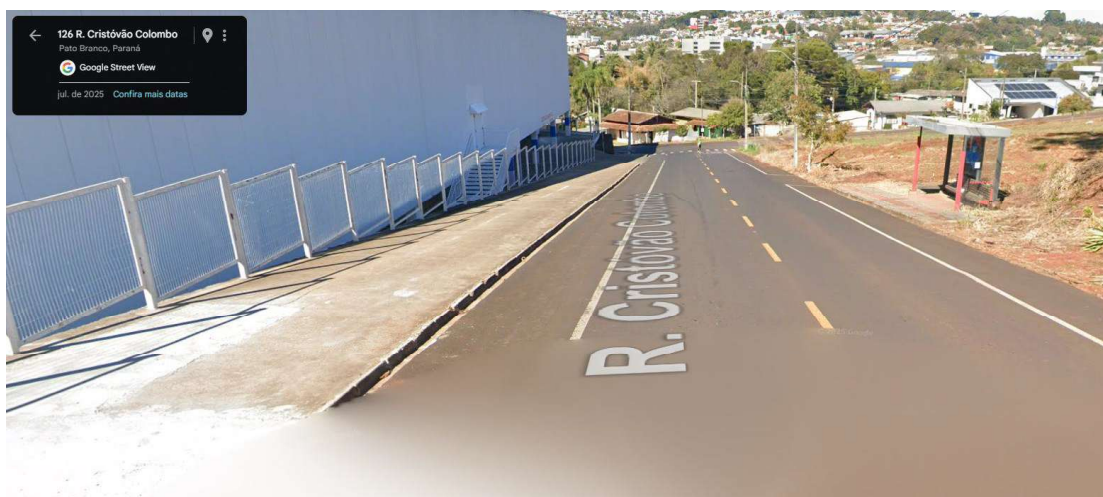
Abrigo na Rua Cristóvão Colombo - fundos da Havan
