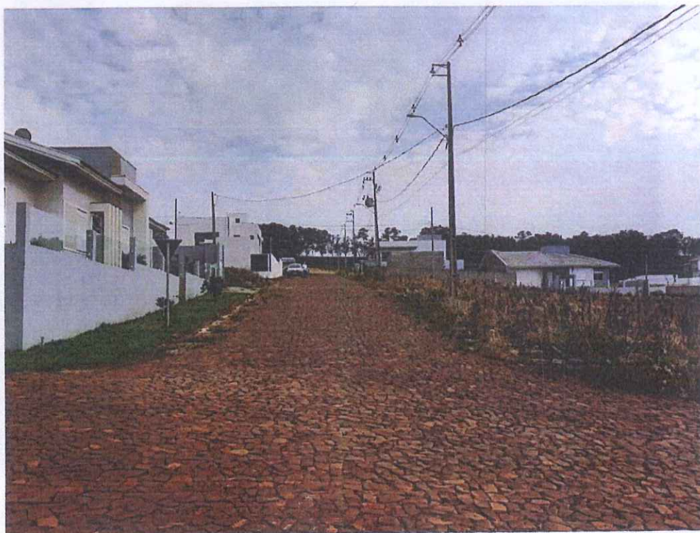
Foto 01 – Vista Geral da Rua das Begônias
