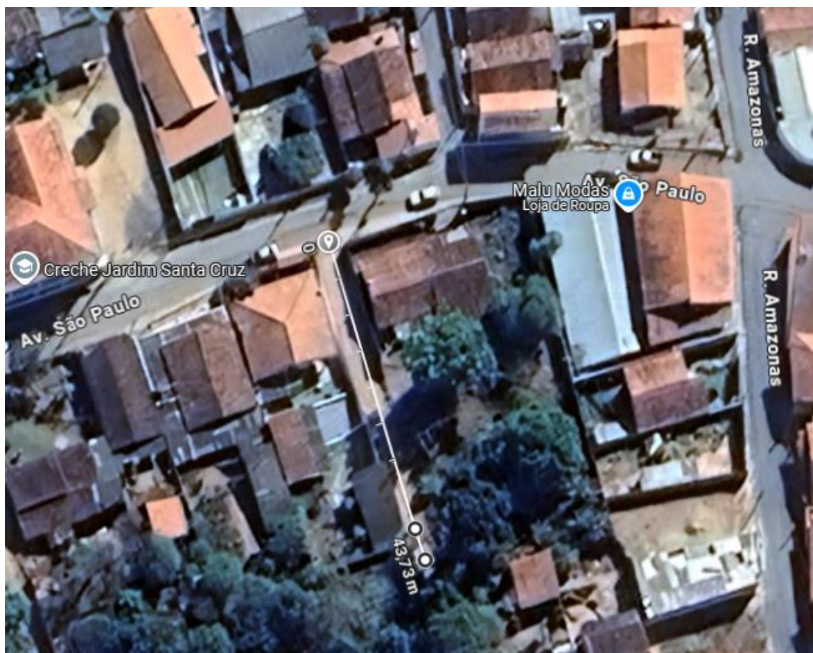
Rua Pará, aproximadamente 44 metros de extensão
