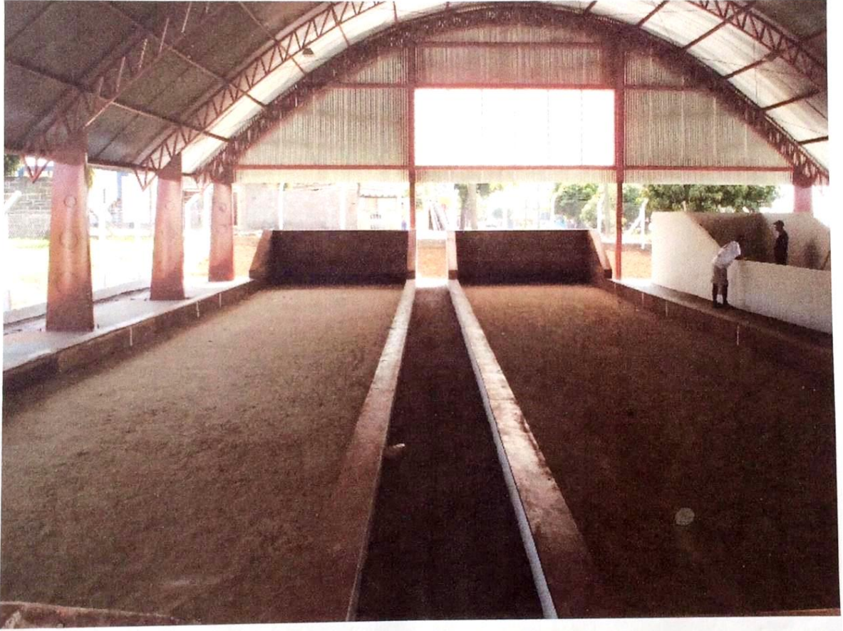
Cancha de Bocha a ser construída
