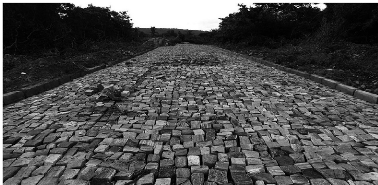
Foto 1 – Construção de Calçamento em Ruas de Porto Alegre do Piauí (05.12.2022)
