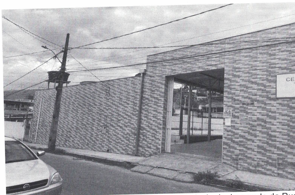
Figura 3 – Vista parcial da extensão do muro frontal do imóvel, observado da Rua Manoel Nero da Silva.
