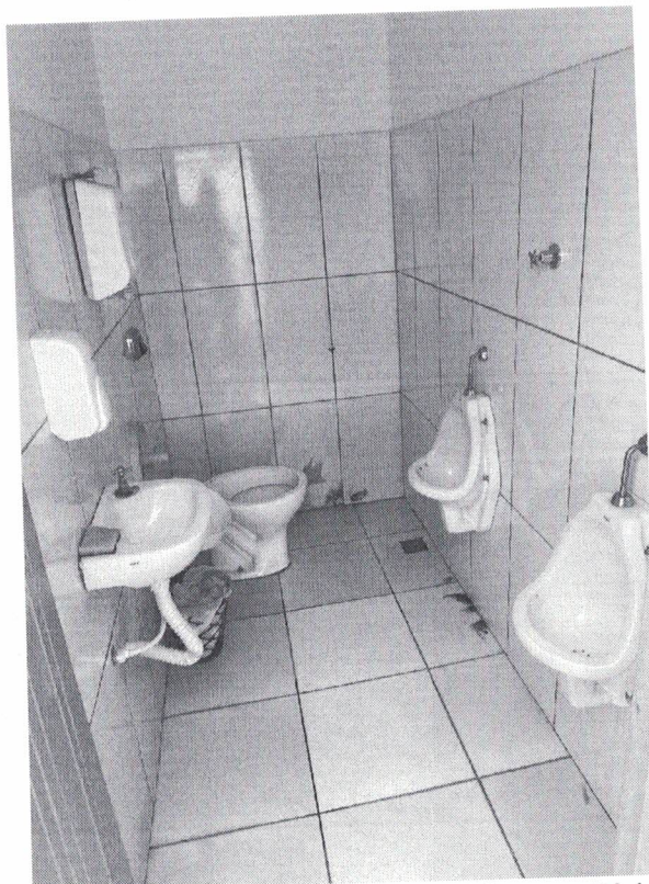
Figura 8 – Vista parcial de uma das áreas dos vestiários do imóvel.
