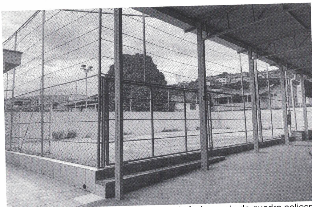
Figura 10 – Vista do hall de acesso aos vestiários e quadra poliesportiva, na região frontal do imóvel.
