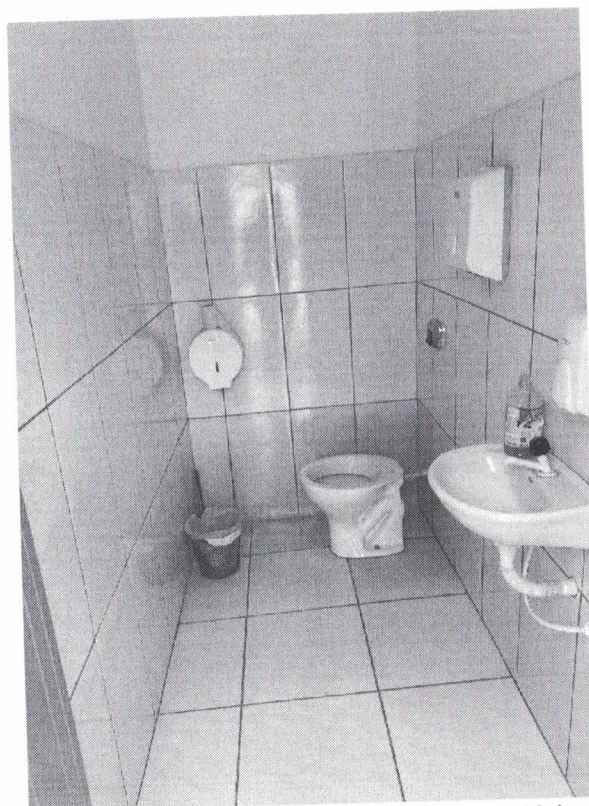
Figura 5 - Vista parcial da área interna dos vestiários do imóvel.
