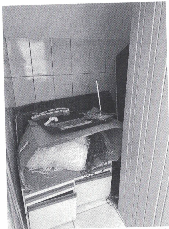
Figura 7 - Vista parcial de uma das áreas dos vestiários do imóvel.
