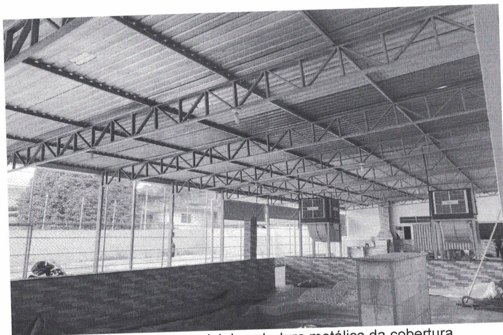
Figura 27 - Vista parcial da estrutura metálica da cobertura.
