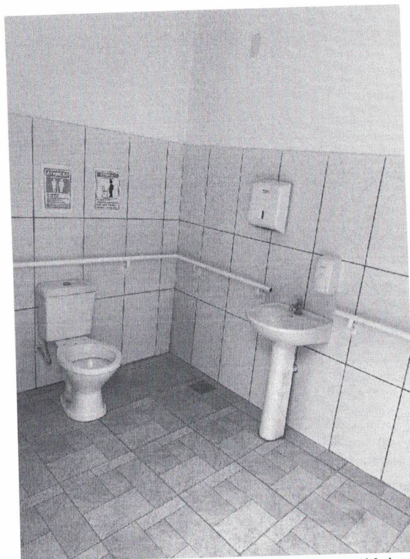
Figura 4 – Vista parcial da área interna dos vestiários do imóvel.
