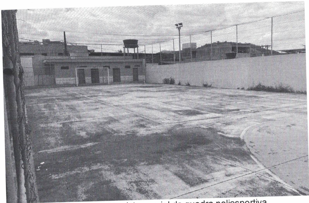
Figura 15 – Outra vista parcial da quadra poliesportiva.
