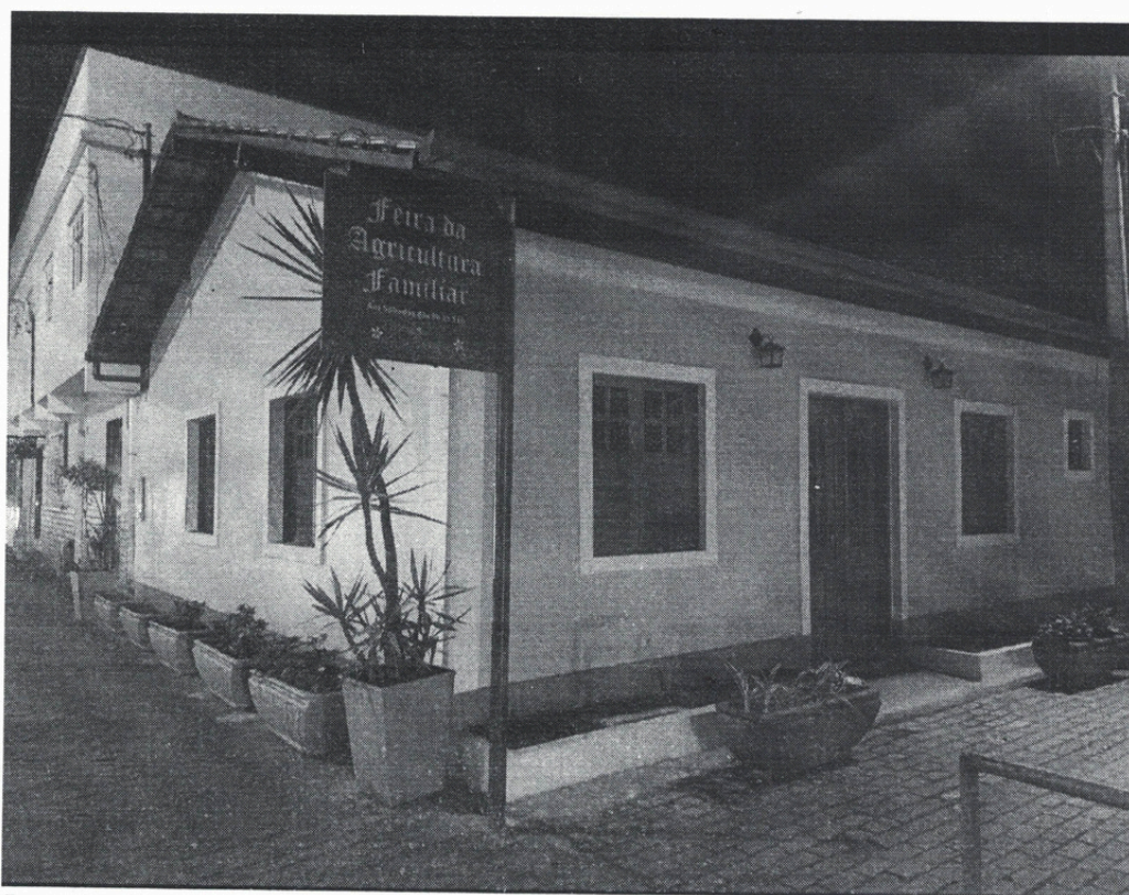
Legenda: Resultado final da reforma – vista lateral
