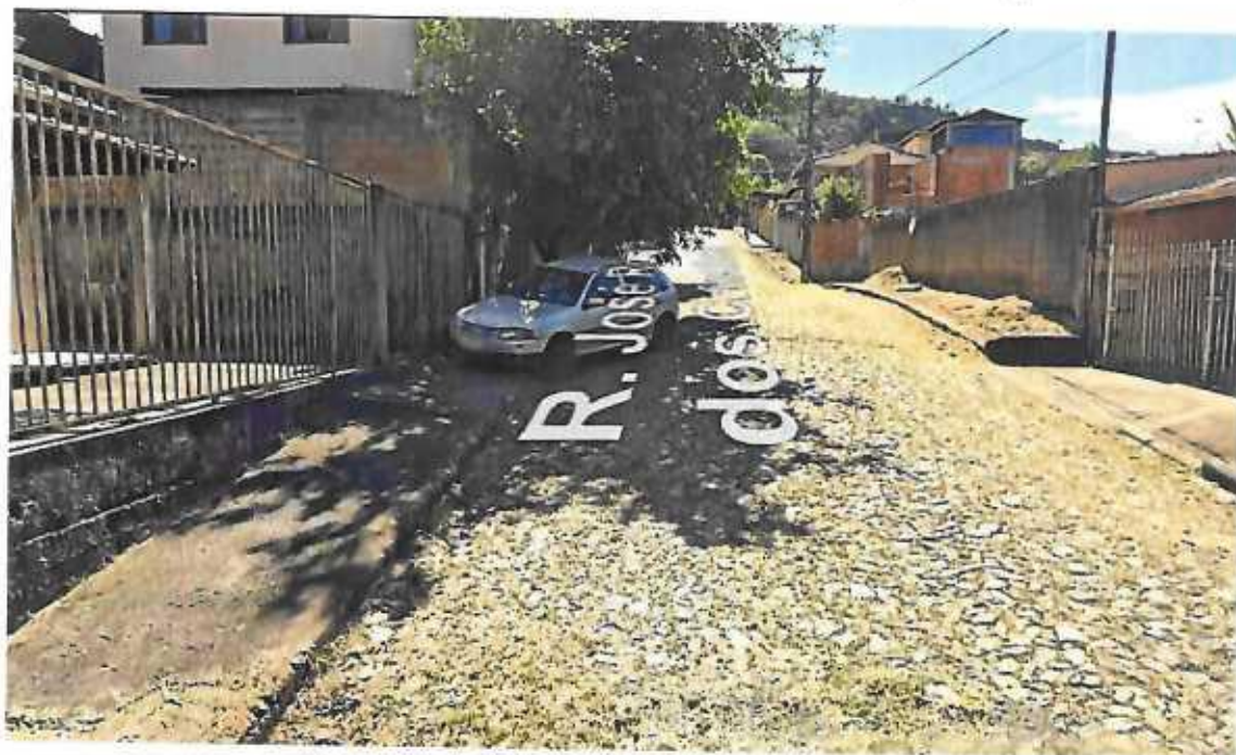
021-Asfaltamento rua José Roque dos Cristãos, antiga rua 24 (Loanda)
