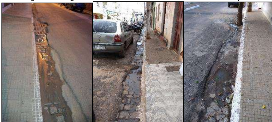
Figura 47 – Esgoto a céu aberto na área central da sede de Caculé/BA
