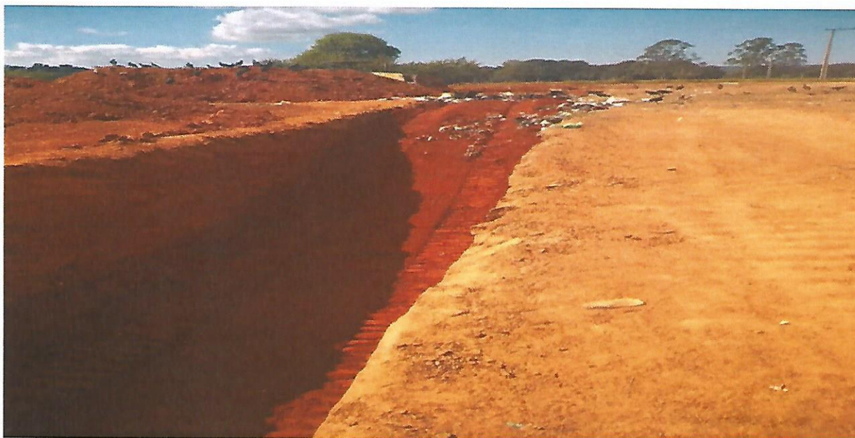
Figura 8 – Aterro em valas controlado pela Prefeitura Municipal
