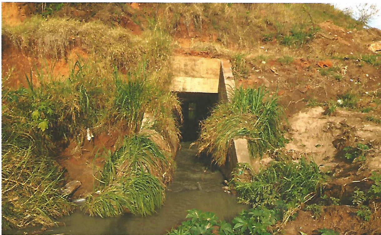
Figura 6 - Galeria de Águas Pluviais da BR 491 (jusante)
