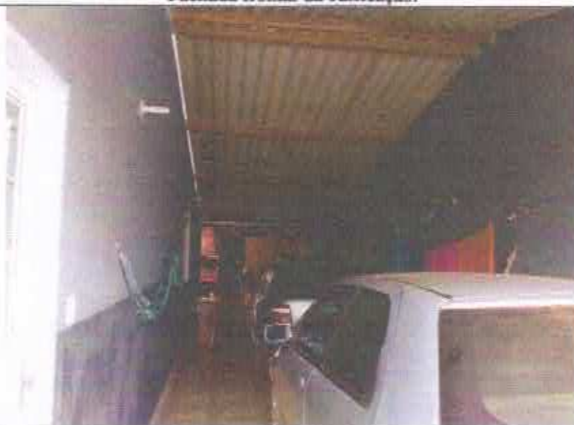
Foto 02 Parte da fachada lateral direita. Na imagem, também é possível ver a área destinada à garagem coberta.
