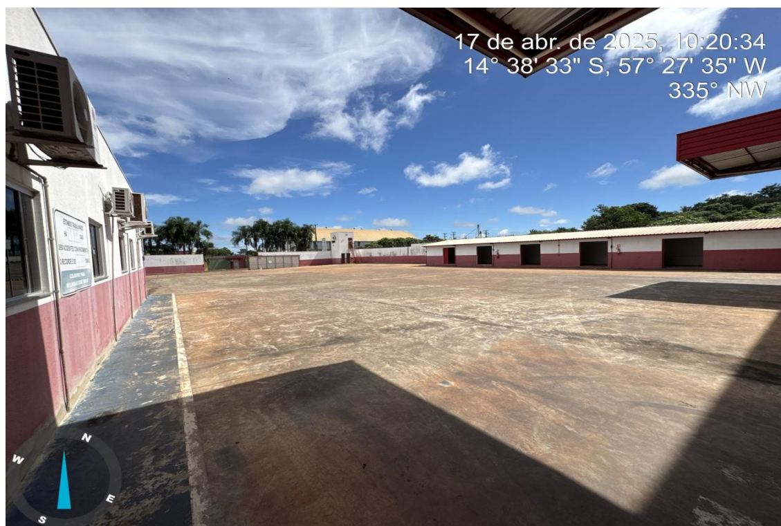
Figura 02 – Edificação comercial, área de pátio, vista interna Elaboração: Departamento de Estudos e Projetos/Seplan
