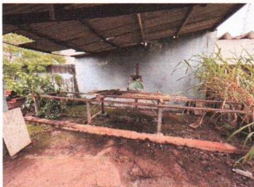
Foto 8: Visão geral da cobertura precária
