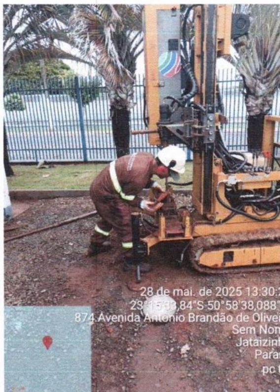
Figura 4 - Sondagem SPT
