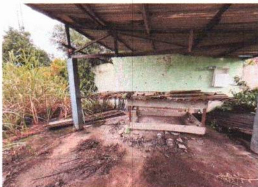
Foto 7: Visão geral da cobertura precária
