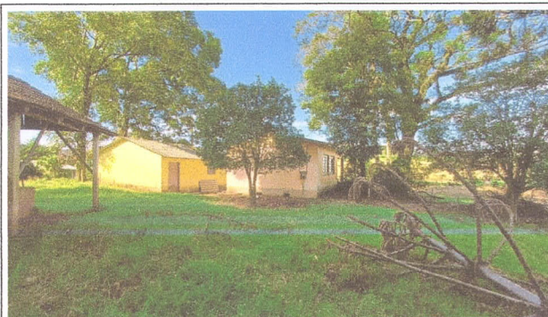
Vista Fundos da Escola, tomada da estrada
