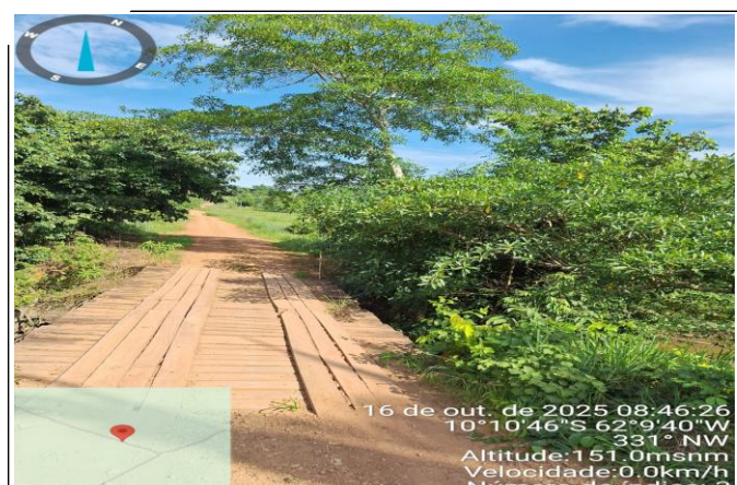
Foto 4: LINHA C 08 LADO DIREITO KM 10,50, EXTENSÃO DA PONTE 10,1 M
