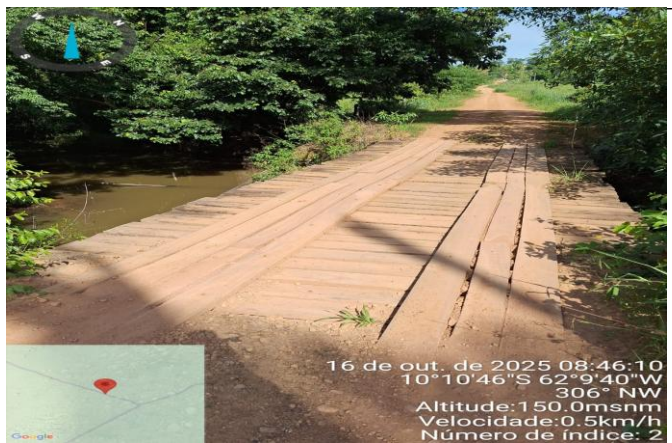
Foto 1: LINHA C 08 LADO DIREITO KM 10,50, EXTENSÃO DA PONTE 10,1 M
