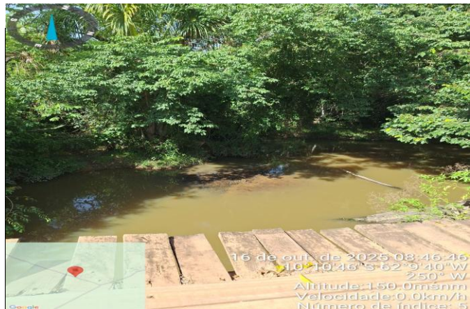
Foto 2: LINHA C 08 LADO DIREITO KM 10,50, EXTENSÃO DA PONTE 10,1 M
