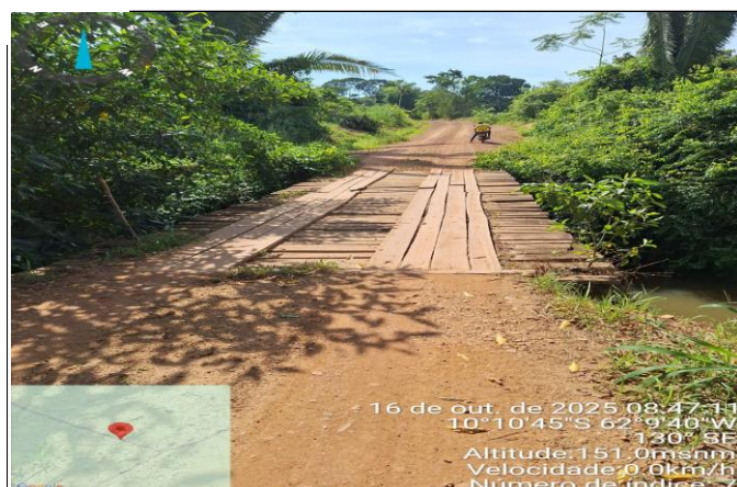
Foto 5: LINHA C 08 LADO DIREITO KM 10,50, EXTENSÃO DA PONTE 10,1 M
