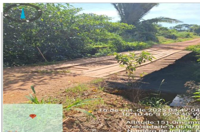
Foto 3: LINHA C 08 LADO DIREITO KM 10,50, EXTENSÃO DA PONTE 10,1 M
