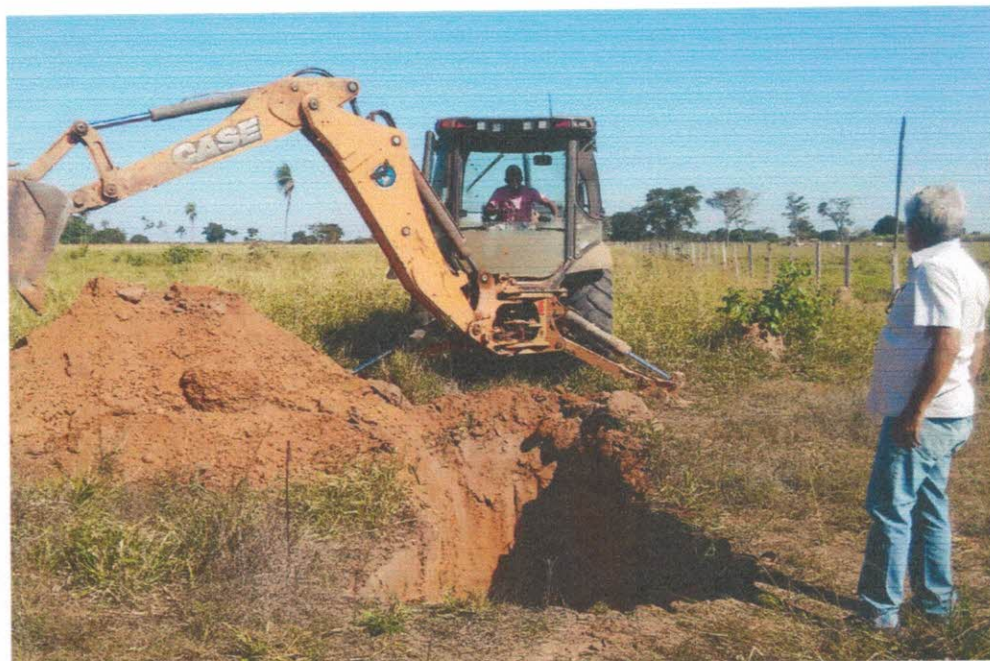
Foto 04 – Cava do Perfil 04 – Solo concrecionário a 1 m de profundidade. Solo superficial serve para sub-base de pavimentação.
