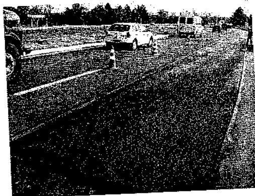
Pintura de Ligação no reparo localizado
