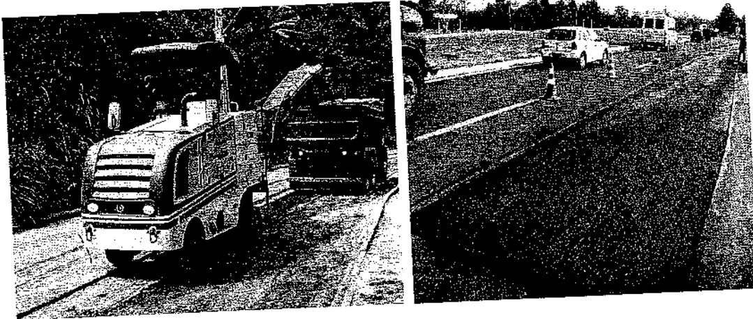
Pintura de Ligação no reparo localizado
