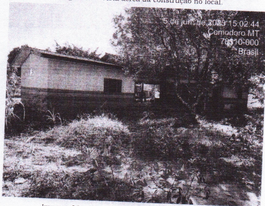
Imagem 06 – Vista terrestre da construção no local.
