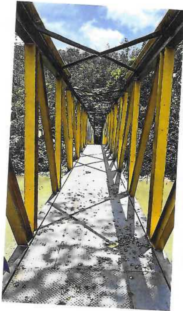
011-Ponte santa cruz
