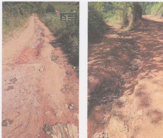
Trecho de estrada do Bairro Castelhana
